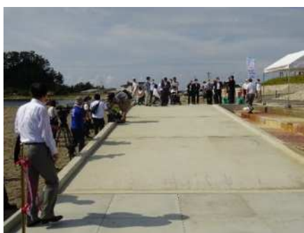
完成した広々としたスロープ
