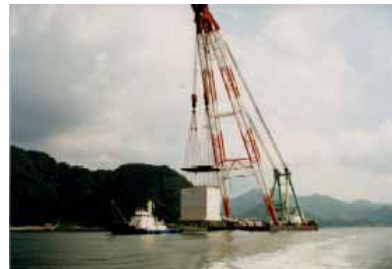
和田地区に曳航中のケーソン
