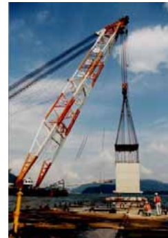
据付け作業の様子
