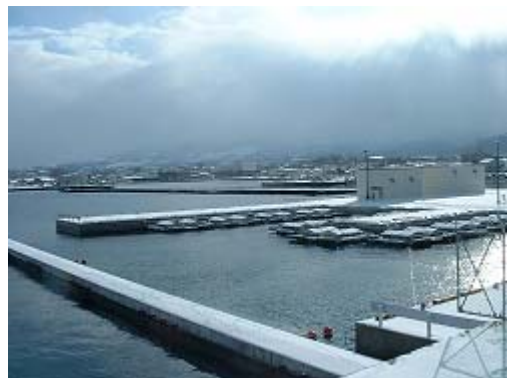
港湾施設用地（水中） 今後の活用に期待が掛かります。
