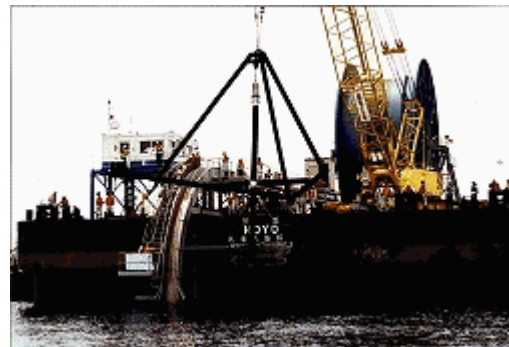
取水口設置の状況
