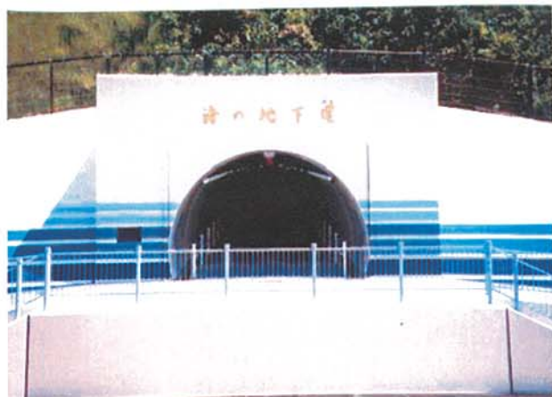
海側トンネル出入口
