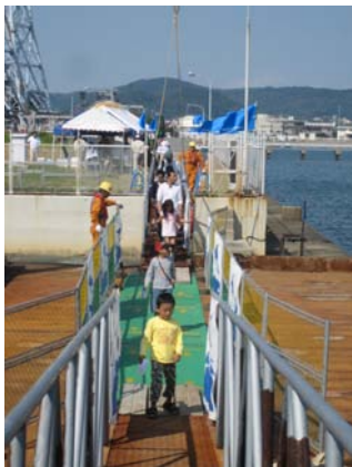
水路に架かった仮設歩道橋
