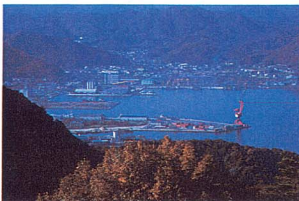
舞鶴西港（五老ヶ岳公園から撮影） 手前から、第2、第3、第4埠頭
