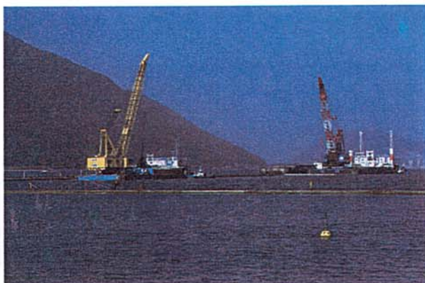
地上から見た(仮称)和田埠頭建設現場
