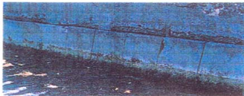
北防波堤側面状況
